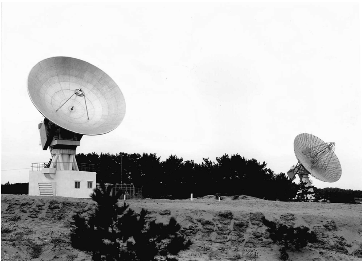
左 送信アンテナ 10mφ 右 受信アンテナ 30mφ (遠方にあり小さく見える。)
